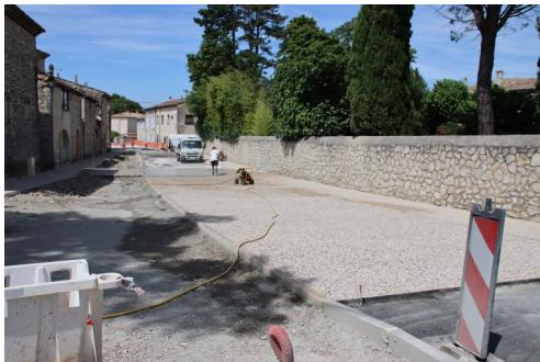
Les travaux d'aménagement se poursuivent... Le 1er tronçon est entré dans sa dernière phase avec la pose des bétons désactivés sur les trottoirs et sur la voie de circulation.
